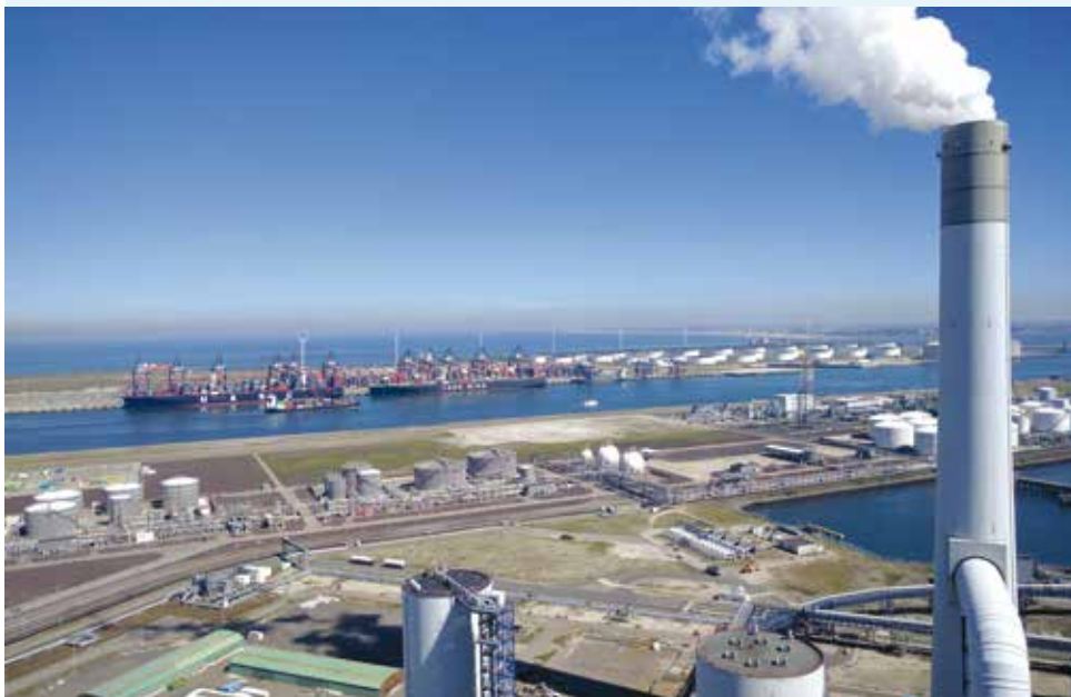
Centrale van Uniper (voorheen E.ON). (BRON: GEMEENTE ROTTERDAM)
