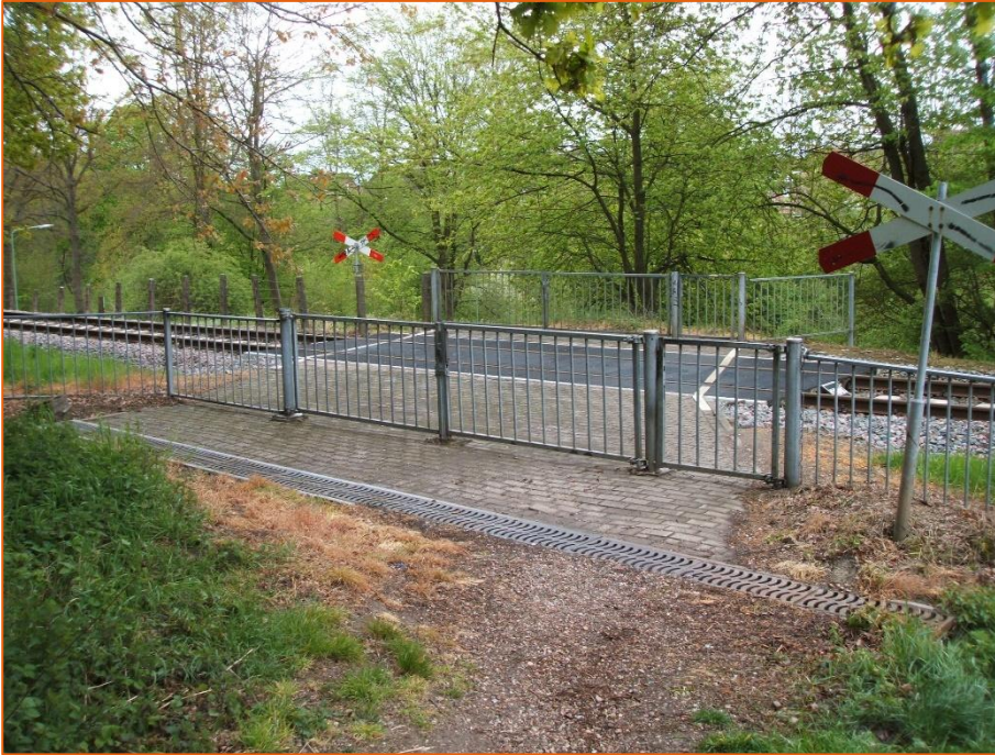
Afbeelding 3, overweg Schoufferbosweg, noordzijde.
