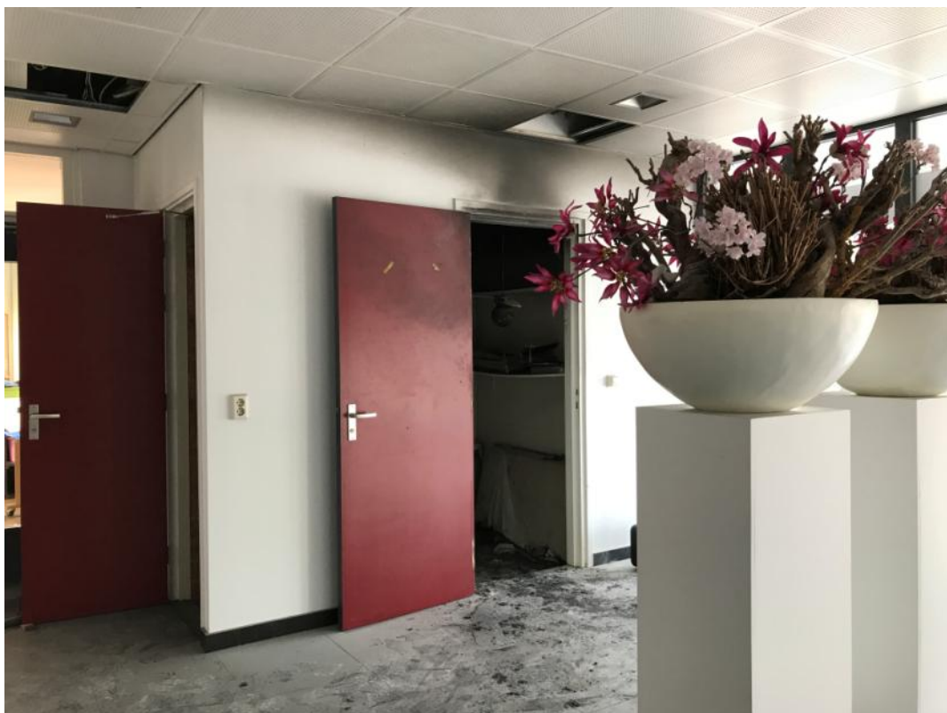
Foto 1 Ingang meterkastruimte, ongevalslocatie
