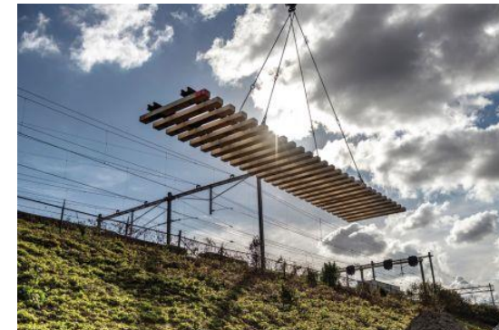
testbaan van 1 km. bij Railcenter Amersfoort
