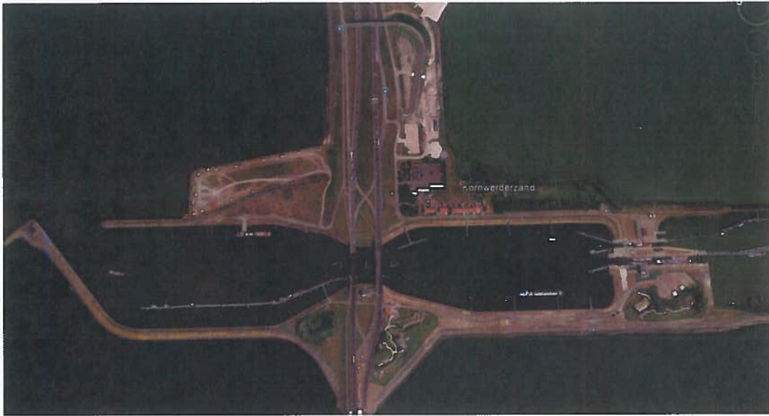
Afbeelding 2.1 Luchtfoto huidige situatie van bruggen en sluis (bron: Google Maps)
