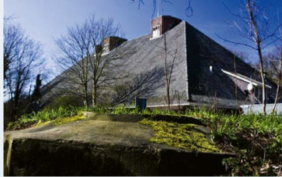
Als boerderij gecamoufleerde bunker van Seyss-Inquart in Wassenaar uit 1943, deel van Stützpunktgruppe Clingendael (Atlantikwall) met eigen tankgrachten en bunkers. Foto: Rijksvastgoedbedrijf.
