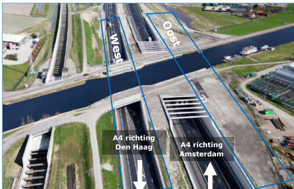
Figuur 0.5: Huidige ligging Ringvaartaquaduct met links de ligging van het oude aquaduct en rechts de ligging van het nieuwe aquaduct uit 2010 en variant Oost
