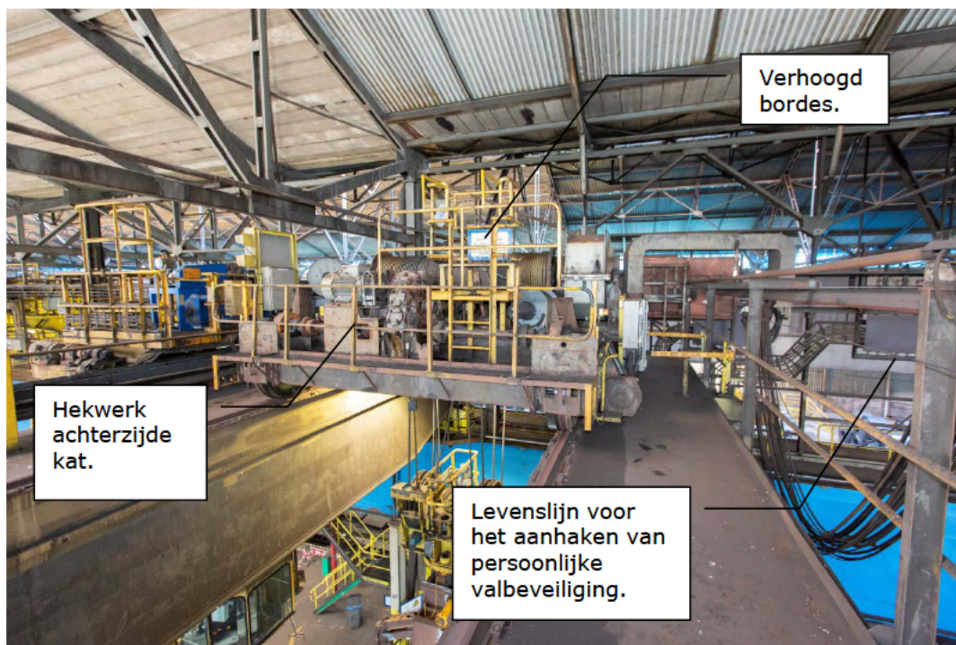
Foto 8: Zicht vanaf de kraanligger op de achterzijde van de kat.
