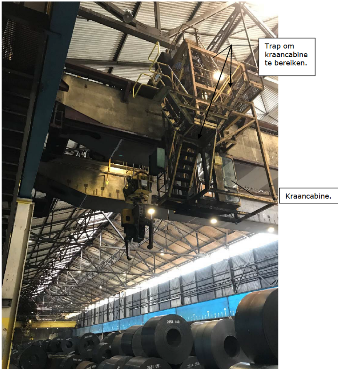
Foto 13: Zicht op kraancabine bovenloopkraan.
