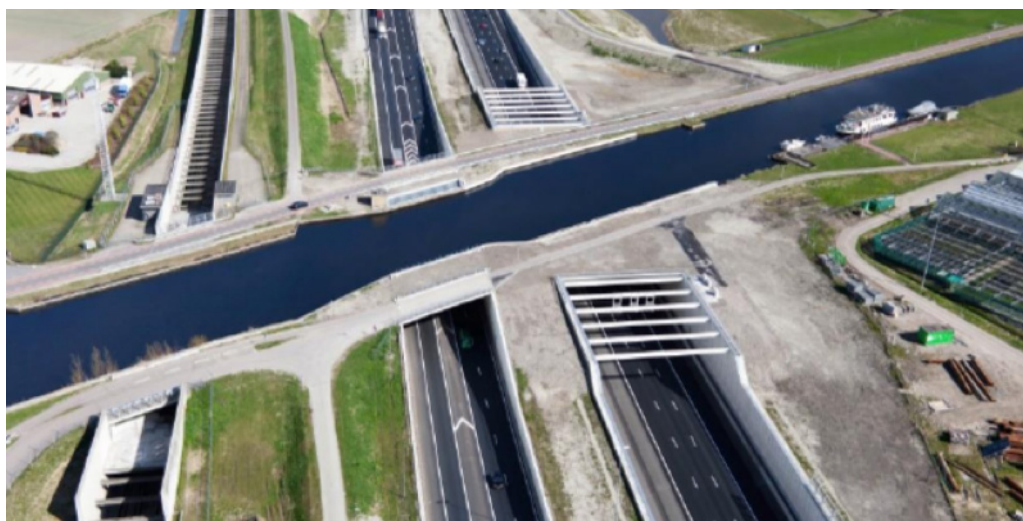
Figuur 3.3: Huidige ligging Ringvaartaquaduct met links de ligging van het oude aquaduct en rechts de ligging van het nieuwe aquaduct uit 2010
