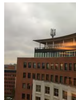
Foto Antenne op daklocatie
