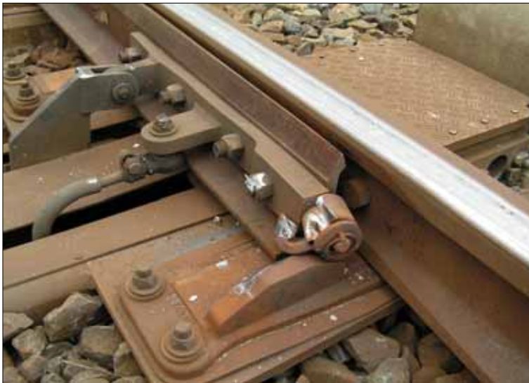
Afbeelding 23: Posities tongen wissel 2519B niet horend bij de positie voor de rijweg naar spoor 31, de aangetroffen positie van de tongen leidt naar spoor 26, de wisseltongen zijn naar rechts verplaatst.
