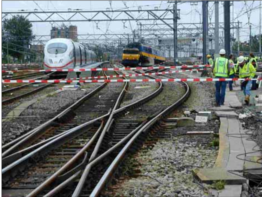
Afbeelding 26: De rijweg van het wissel 49/57A via de boog naar wissel 2519B voor het herstel.
