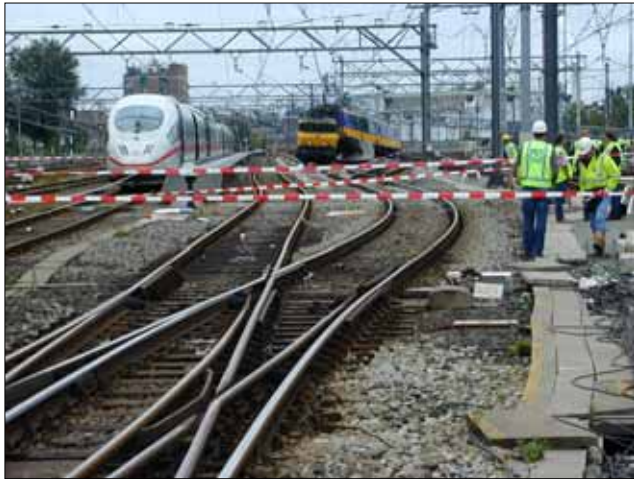
Afbeelding 20: Wissel 57A waar de eerste sporen van de ontsparing zijn gevonden ter hoogte van de vrijbalk en op de achtergrond de ontsparde trein.
