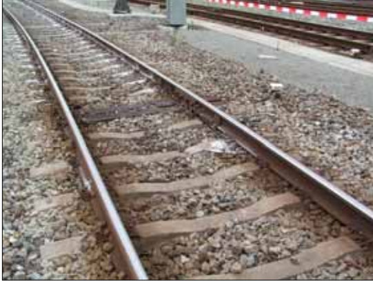
Afbeelding 22: Eerste beschadiging aan dwarsliggers als gevolg van de ontsporing.
