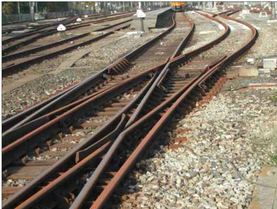
Afbeelding 27: De rijweg van het wissel 49/57A via de boog naar wissel 2519B na de herstelwerkzaamheden. De herstelde schade bevindt zich een 30-tal meter voorbij het wissel 57A.
