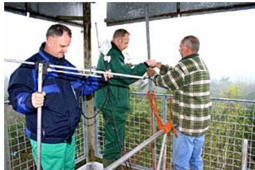
Figuur 8, het plaatsen van een nieuwe zendantenne voor de lokale omroep Ooststellingwerf
