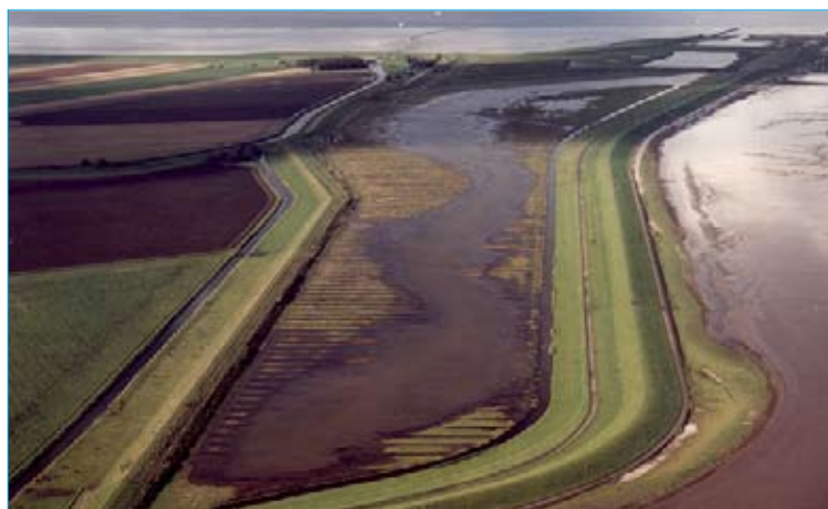
Foto 26 Overslagdijk bij Zeeland
