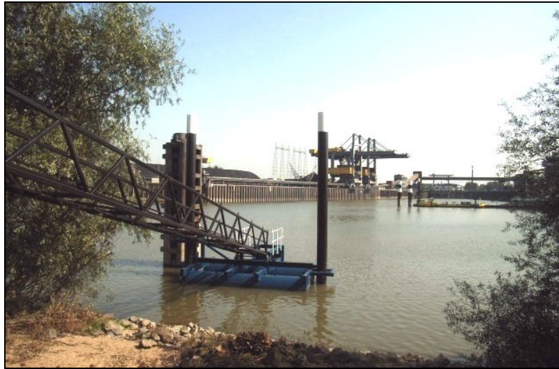
Palen met ponton in de voorhaven Weurt
