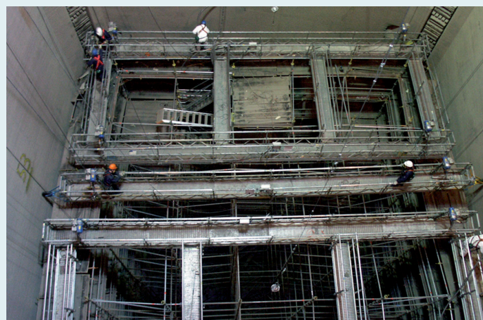
Figuur 13 Bovenaanzicht met hangbruggen; onder de hangbruggen is de steiger zichtbaar
