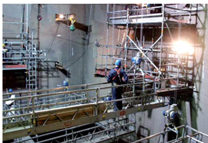
Figuur 11 Binnenzijde van de ketel met hangbruggen en bordessen
