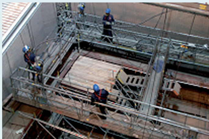
Figuur 12 Demontageploeg aan het werk op de hangbrug
