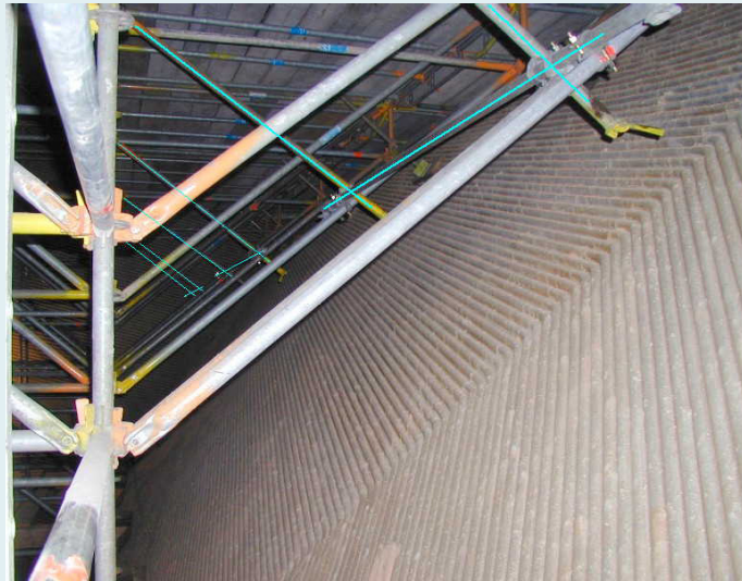
Figuur VII-7 Dubbele schoren, evenwijdig aan trechterwand, zijn onderling gekoppeld i.v.m. uitbuigen en voorzien van knikverkort
