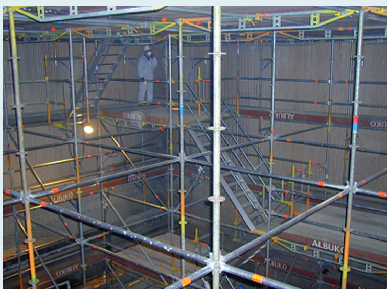
Figuur 5 Bovenste gedeelte van de steiger
