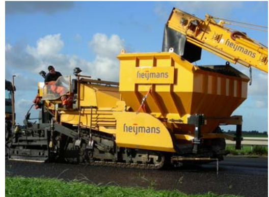
figuur 5 – asfaltspreidmachine met inzetbak
