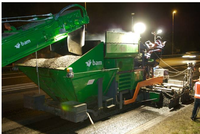
Figuur 3: Twee Laags Asfalt Systeem (TAS)
