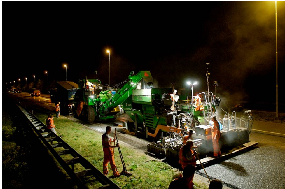
Figuur 19: foto van de nachtelijke werkzaamheden
