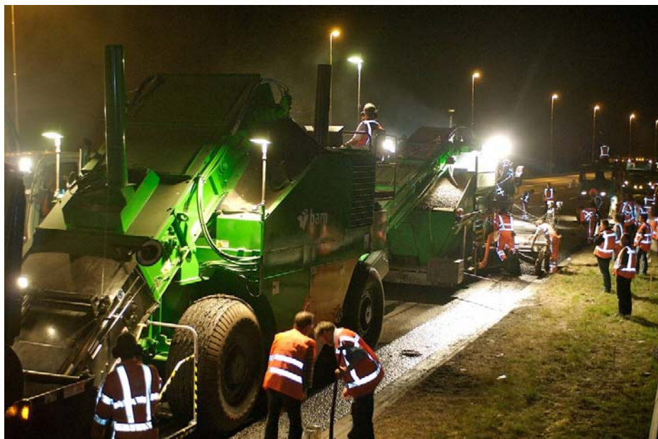
Figuur 20: Shuttle Buggy laadt de spreidmachine (TAS)
