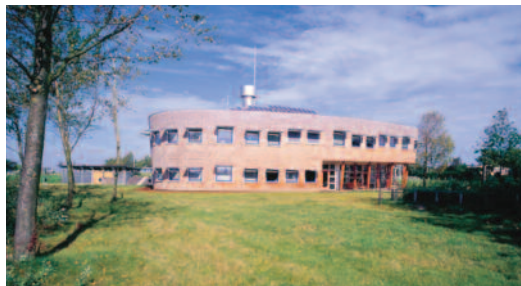
Afb. 5: Kantoorgebouw Rijkswaterstaat in Terneuzen. Zowel bouwkundig als installatietechnisch zijn veel bijzondere maatregelen toegepast zoals de natuurlijke ventilatie en de shingels van afgedankte meerpalen voor de gevelbekleding. Architect: Bureau opMAAT. Realisatie: 2000.
