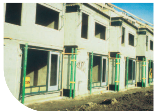
Afb. 33: 100% puingranulaat in het project 'Delftse Zoom in Delft'. In de circa 270 woningen werd voor een aantal prefab betonnen onderdelen het grind volledig vervangen door menggranulaat. Dit mengsel bestaat uit minstens 50% betongranulaat. Architecten: Inbo Architecten, Architectenbureau Galis en Baneke - Van der Hoeven Architecten. Realisatie: 1998.
