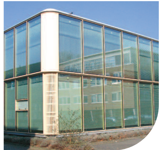
Afb. 13: Kantoorgebouw XX te Delft met een geplande levensduur van 20 jaar.
