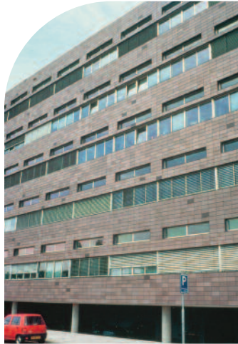
Afb. 42: Belastingkantoor Enschede Zuidgevel van de nieuwe uitbreiding van het belastingkantoor in Enschede. Het gebouw is een goed voorbeeld van optimaal gebruik van natuurlijke ventilatie en daglicht. Een koelinstallatie kon achterwege blijven. Architect: Ruurd Roorda - Rijksgebouwendienst/DO&T te Den Haag. Realisatie: 1996.
