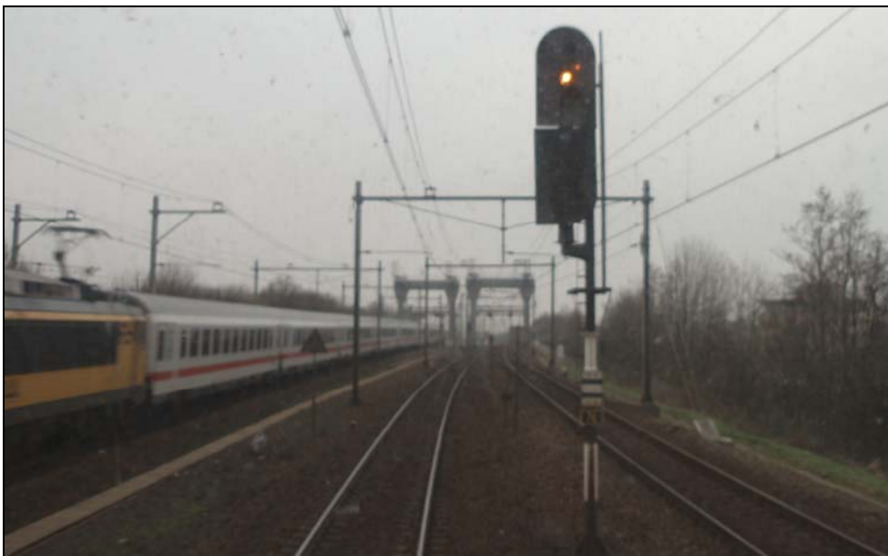
Afbeelding 9: Sein 76 met daarachter de brug over de Vecht. Het seinbeeld op de foto is geel. Tijdens het incident toonde het sein rood.
