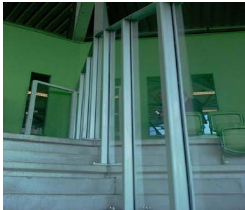
Figuur 13: Lexan-wand op bovenring
