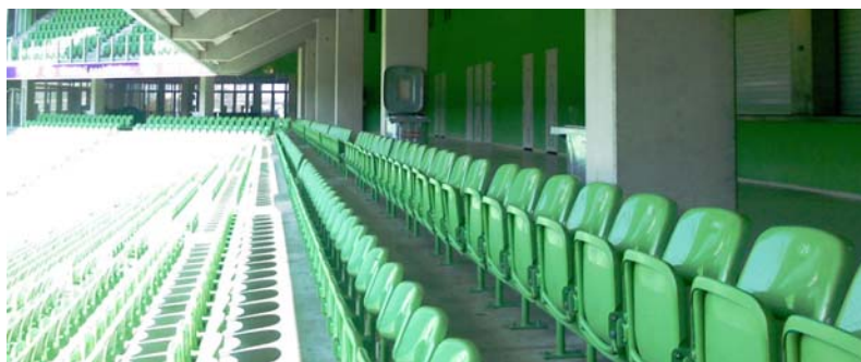
Figuur 25: De uitgang is vanaf de tribune duidelijk zichtbaar
