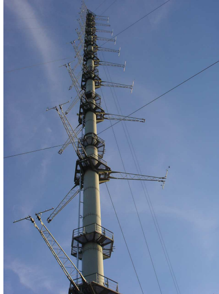
(b) Sonische anemometer op de mast. (c) De meetmast van Cabauw vanaf de grond.
