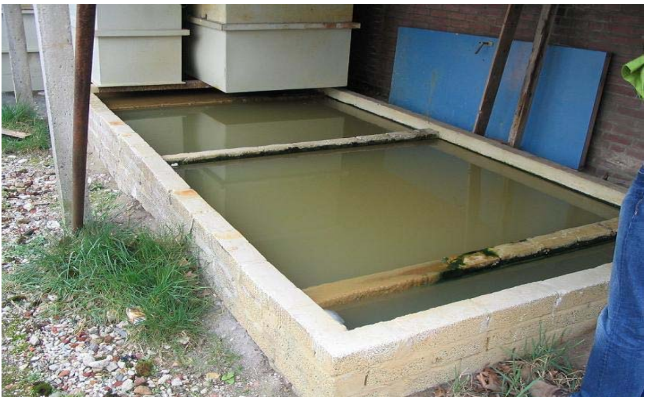
Figuur 6: bezinkselafscheider van de waterzuivering van een galvanisch bedrijf binnen een waterbeschermingsgebied.
