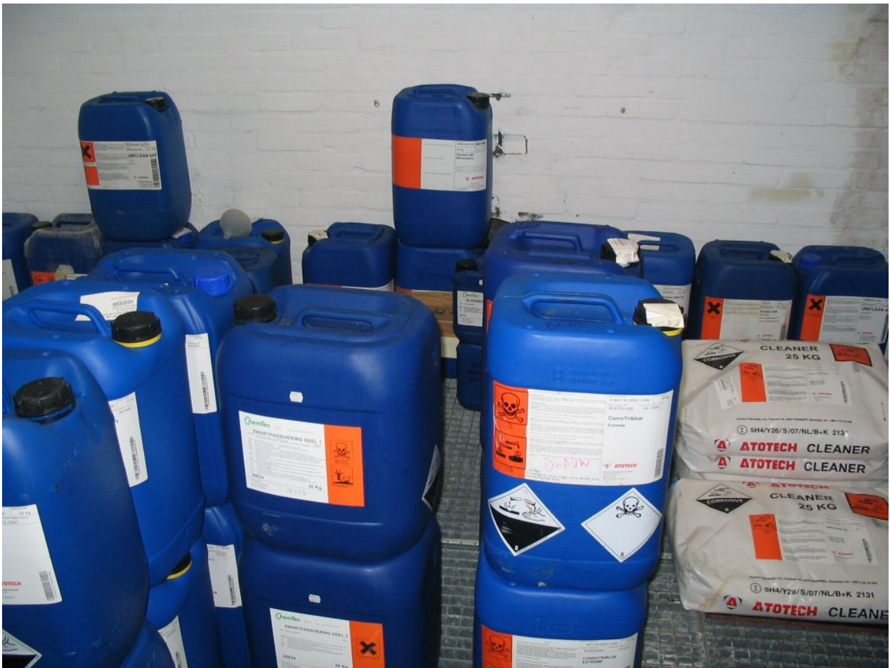
Figuur 3: opslagruimte voor gevaarlijke stoffen bij een galvanisch bedrijf: let op belemmering ventilatiekanaal middenin.
