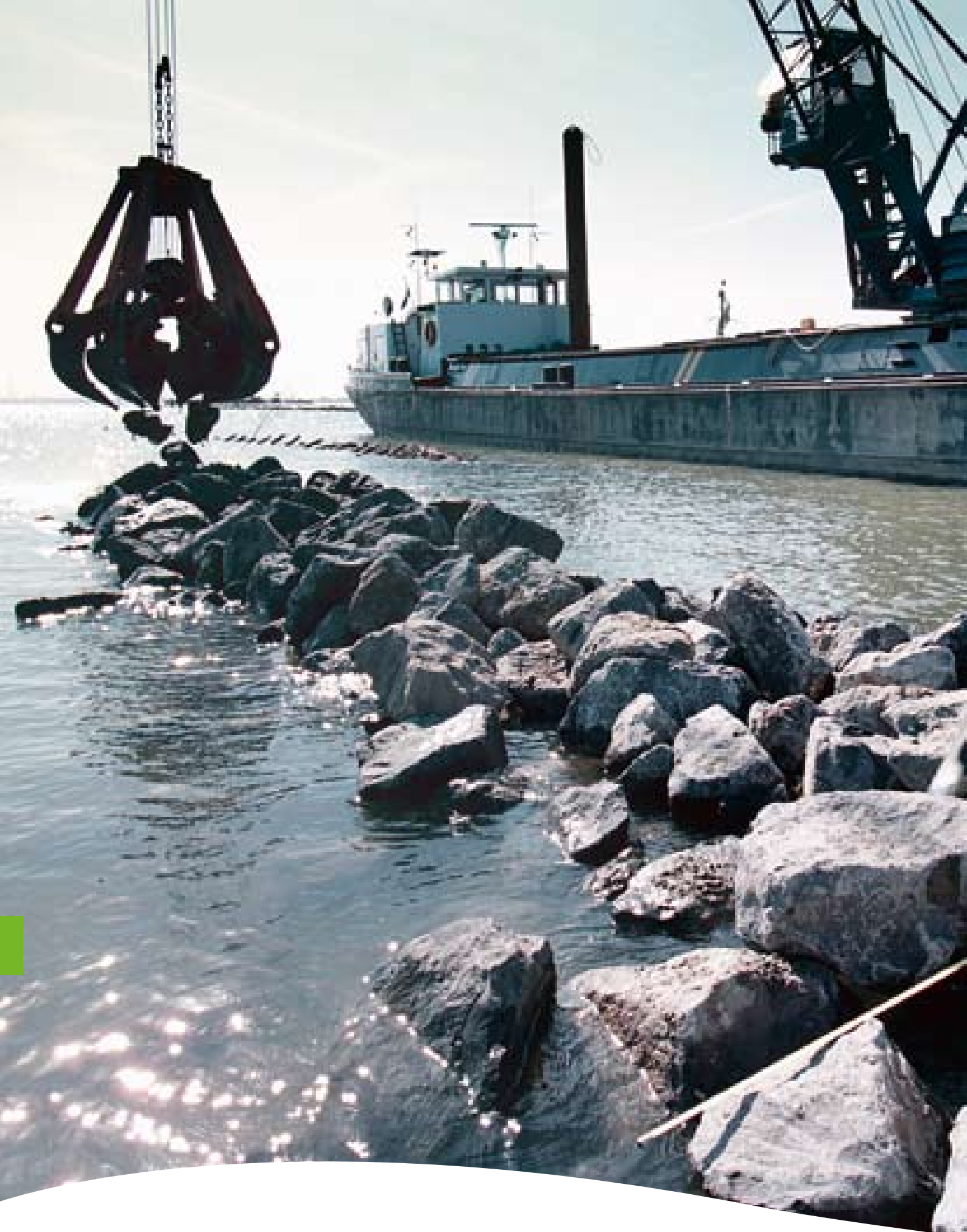
Werkzaamheden aan strekdam in Hollandsch Diep bij Strijensas
