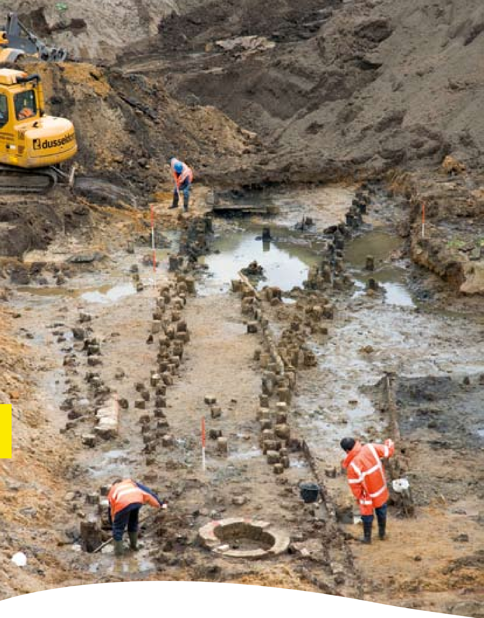
Resten van een stuw en beschoeiing uit de nieuwe tijd in de voormalige Molenbeek te Ulft
