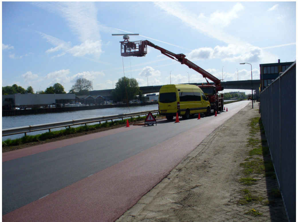
Figuur 24: Testopstelling Maarsssen 1
