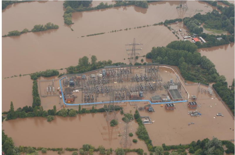
Figuur 3 Walham elektriciteit substation zomer 2007.
