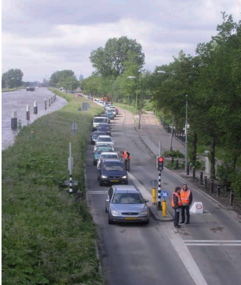
Figuur 3.4: Verkeersdoseerinstallatie in Midden-Delfland
