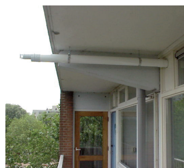
Gesloten geiser met doorvoer onder het balkon (Vestia Den Haag Zuid-Oost)
