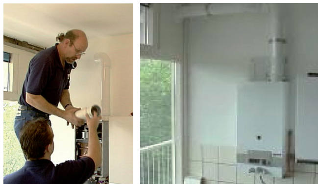
Gesloten geiser met doorvoer onder het balkon (Vestia Den Haag Zuid-Oost)
