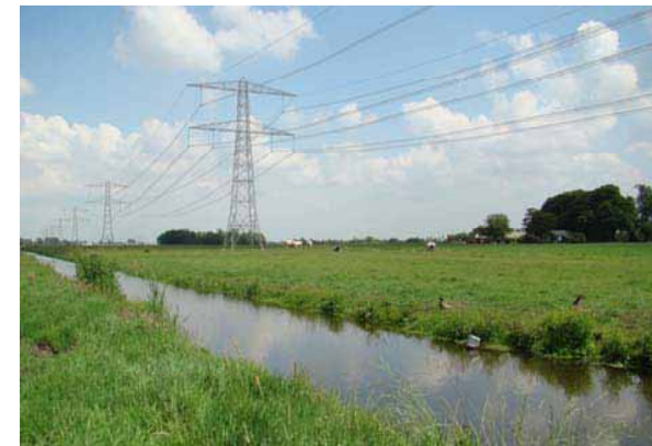
Voorbeeld huidige situatie: een 2 circuitsverbinding in een vakwerkmast
