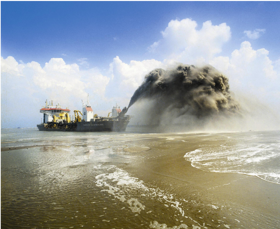
Figuur 4.4 Vooroeverstoppingen via het zogenaamde 'rainbowen'
