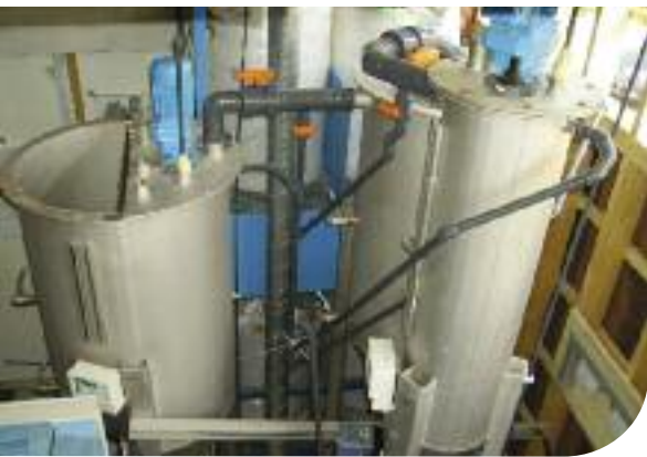
Installatie voor het zuiveren van water en produceren van biogas in de wijk.
