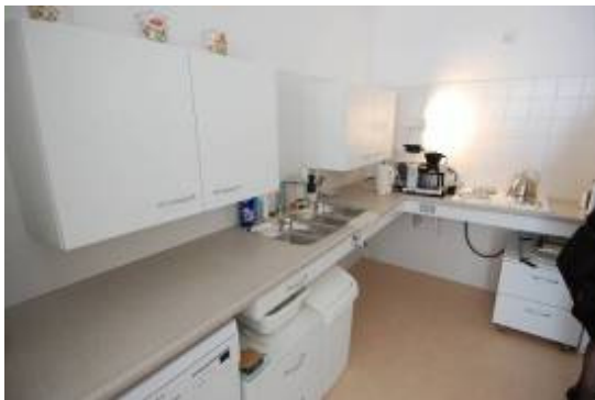
Aangepast onderrijdbaar keukenblok
