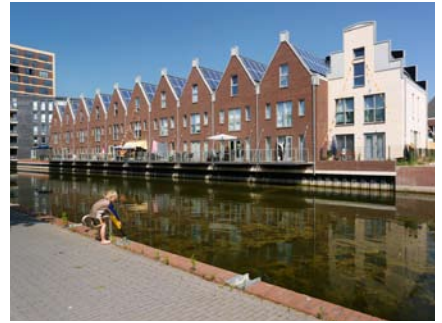
Nieuwbouw en Herstructurering
