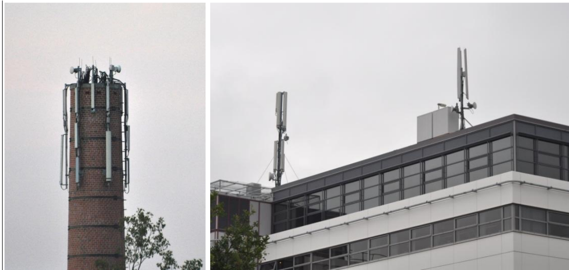
Figuur 6: Site-sharing op een schoorsteen en een dak
