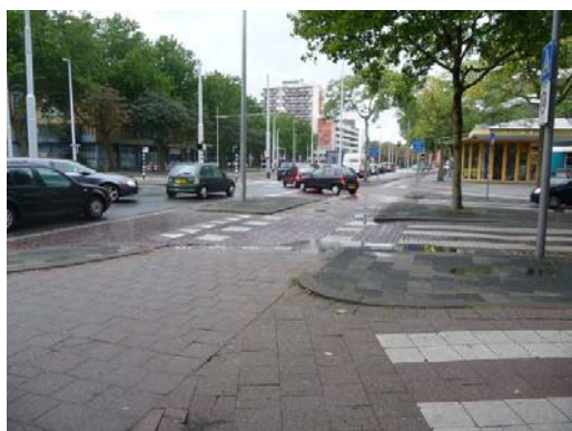
Linksafvak blokkeert rechtdoor en rechtsaf
