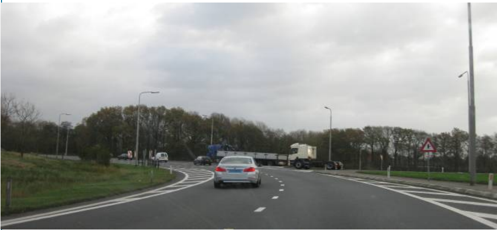
De rotonde ter hoogte van de toerit vanaf de A6 HRR.
