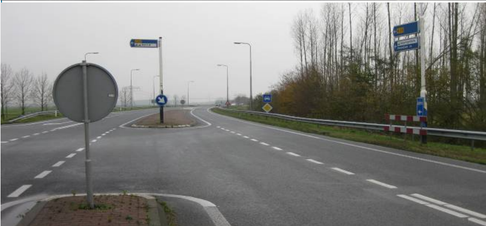
Zicht op de T-splitsing vanaf de opstelstrook voor linksafslaand verkeer op de N33 komende vanuit Delfzijl.
