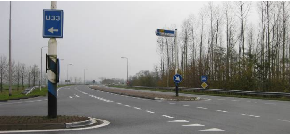
Zicht vanaf de N362 op de N33 richting Veendam. Links is de opstelstrook voor rechtsafslaand verkeer te zien. De bewegwijzeringmast links op de foto beperkt het zicht enigzins.
