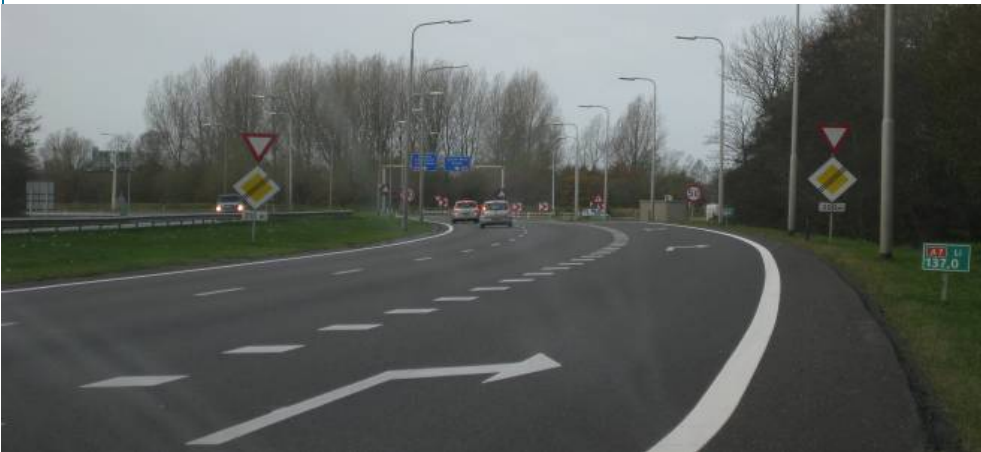
De A7 HRL ter hoogte van knooppunt Joure met rechts de uitvoegstrook van de bypass naar Joure.
