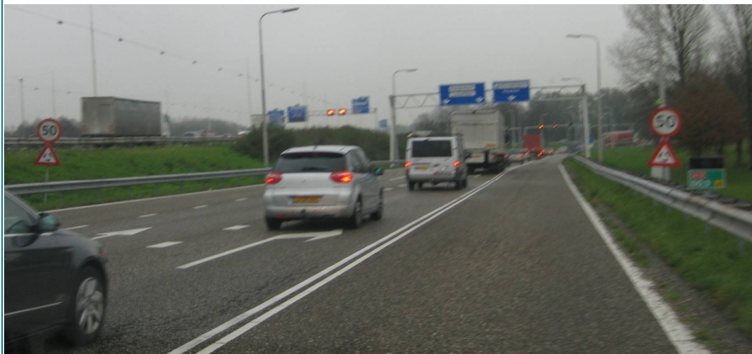
Aan weerszijden van de afrit wordt met bebording de maximumsnelheid aangegeven, alsmede voor de rotonde gewaarschuwd.
