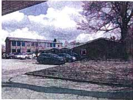
figuur 6 Zicht op het dak laagbouw
