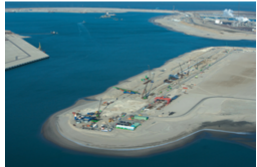
Foto: Kade APMT in aanbouw (februari 2012)
