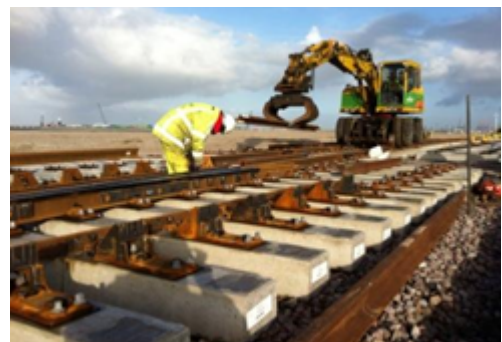
Foto: Spoorwerk in uitvoering (december 2011)
