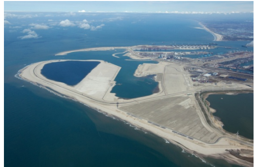
Foto: Luchtfoto Maasvlakte 2 in aanleg (juni 2012)
