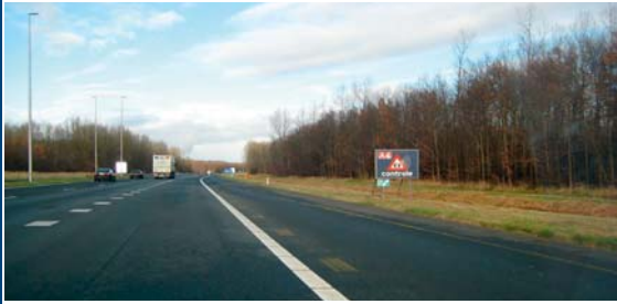
Tijdelijke belijning toerit (aansluiting 11) nog zichtbaar.
