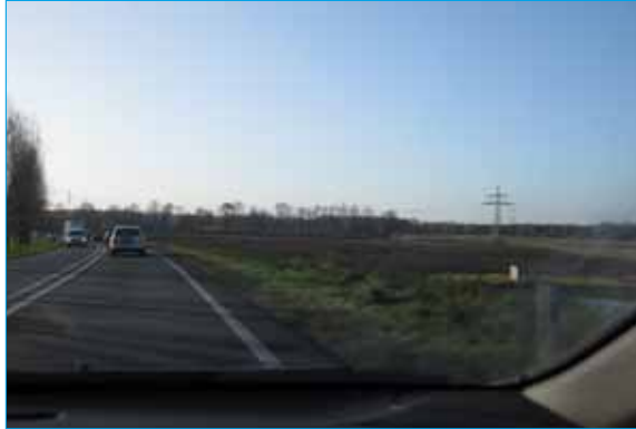
Foto 5: In de bocht nabij bedrijventerrein Twente is in de buitenbocht geen visuele geleiding aanwezig
