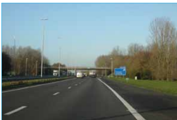
Foto 4: Door de aanwezigheid van het viaduct en de bomen ter hoogte van de aansluiting Vaasen (hm 215,3) is er sprake van een visuele vernauwing
