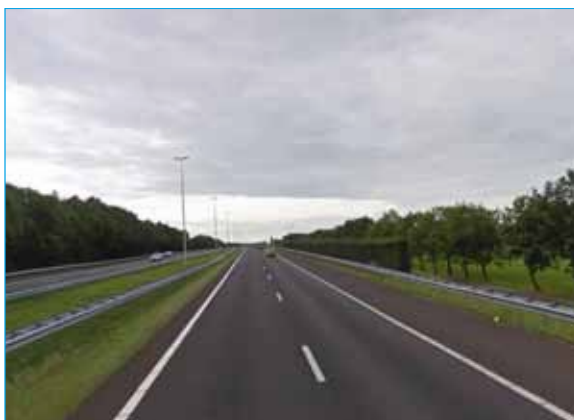
Foto 2: Om de visuele vernauwing ter hoogte van hm. 208,8 te verminderen wordt voorgesteld om de overgang van de brede buitenberm naar de situatie met het geluidsscherm direct achter de geleiderails geleidelijker te maken.
