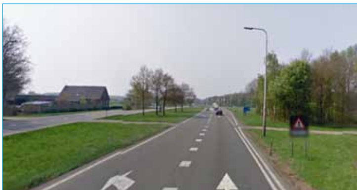
Foto 4: Oversteek N18 ten noordoosten van het kruispunt. Het bord om weggebruikers te waarschuwen staat pas ter hoogte van de opstelstroken.
