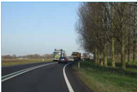
Foto 4: Door de aanwezigheid van een bomenrij hebben weggebruikers weinig zicht op het verloop van de bocht nabij bedrijventerrein Twente
