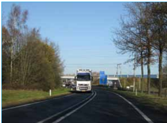
Foto 2: Door de aanwezigheid van het spoorviaduct hebben weggebruikers pas laat zicht op de bocht naar links en de rijbaanscheiding die in de bocht begint (zie ook de volgende foto waarop het begin van de rijbaanscheiding net zichtbaar is
