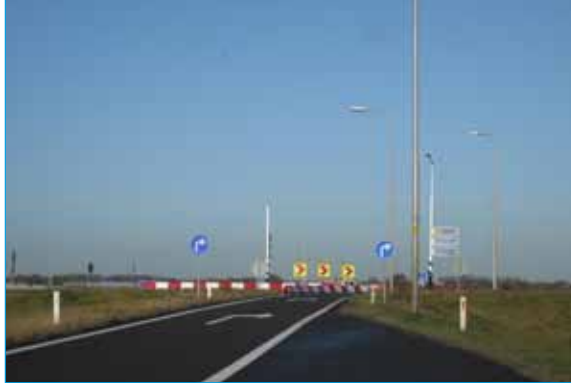
Foto 1: Het kruispunt aan het einde van de afrit van de A35 is aangepast zodat weggebruikers hier alleen nog maar rechtsaf de N36 op kunnen rijden
