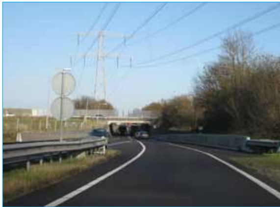
Foto 6: Het begin van de rijbaanscheiding van de aansluiting Bedrijventerrein Twente ligt in een bocht
