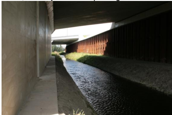
foto 7, tunneltje als faunapassage
