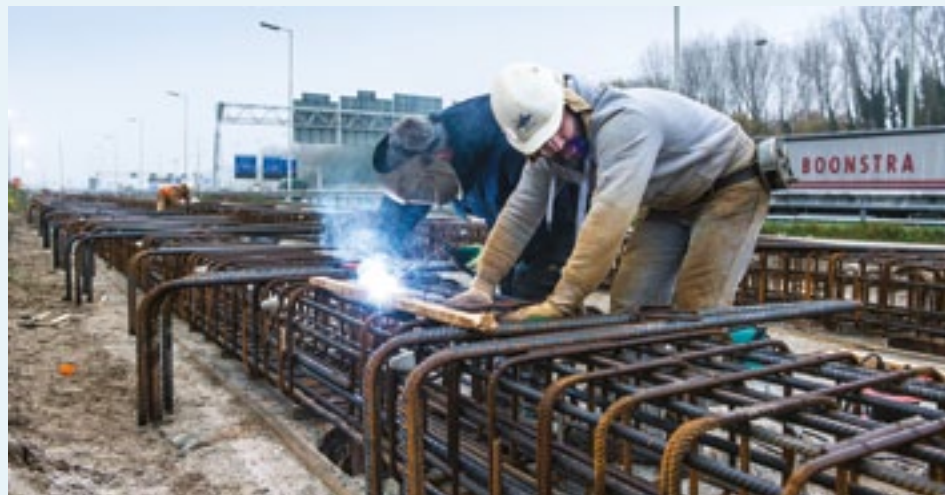
Aan de verbreding van de A15 wordt dag en nacht doorgewerkt. (BRON: HOLLANDSE HOOGTE)
