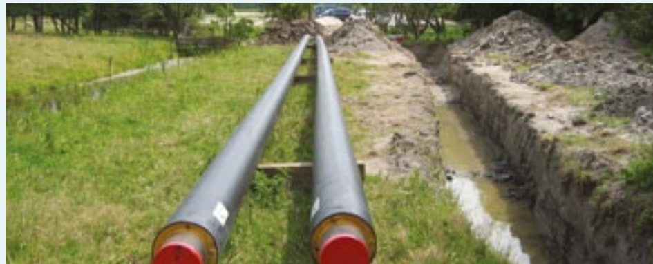
Verwarmingsbuizen liggen klaar om afvalverwerker AVR te verbinden met woonwijken op Zuid. (BRON: WARMTEBEDRIJF ROTTERDAM)
