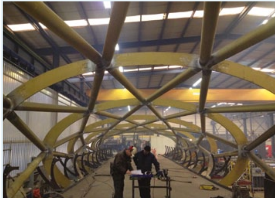
Fabricage van de "netkous-brug" ten behoeve van de Groene Verbinding in de fabriek van VDS Staal- en Machinebouw B.V. te Nieuwdorp (Vlissingen-Oost).
