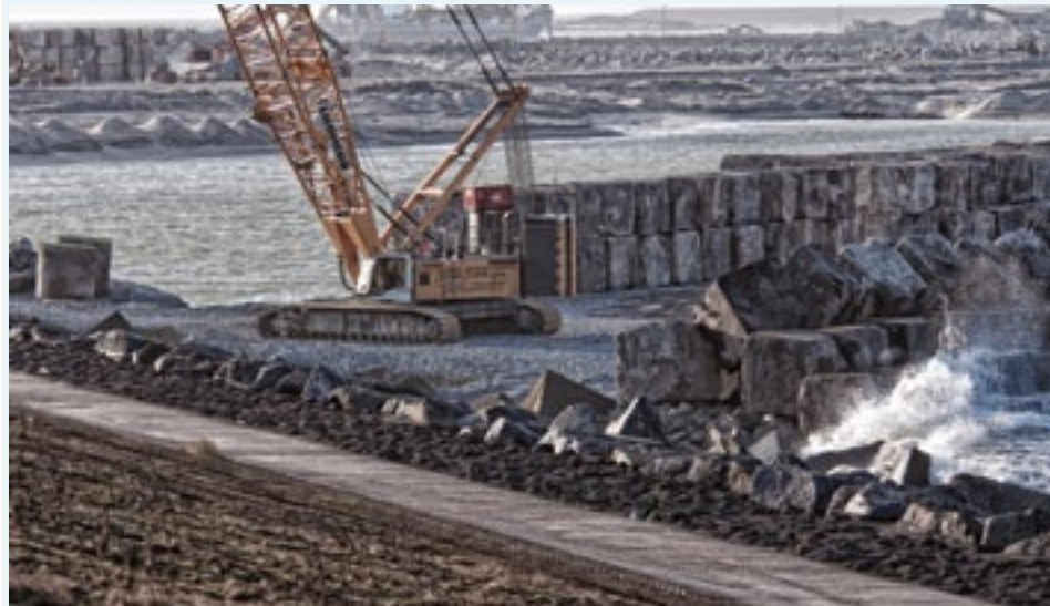
Blokken uit de oude zeewering van Maasvlakte 1 worden hergebruikt. (BRON: ROB VAN DER WAAL)
