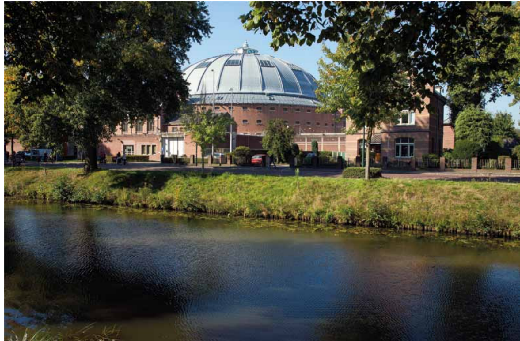
De Boschpoort in Breda (1886, architect Johan Metzelaar) is een van de drie koepelgevangenis in Nederland. Het Rijk wil het gebouw in 2016 afstoten.
