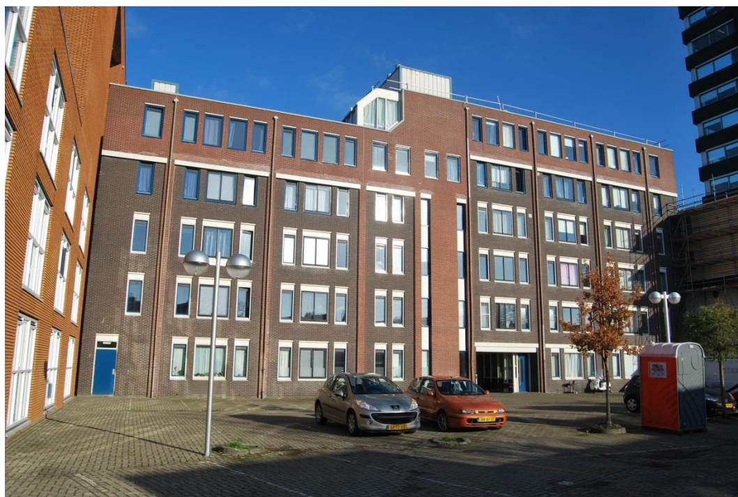
Studentenwoningen in voormalig kantoorpand, Eendrachtskade in Groningen (Lefier StadGroningen)
