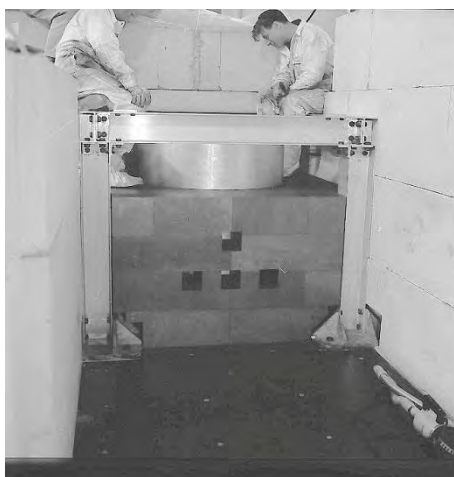
Figuur 5 Plaatsen van de uitwendige grafietreflector rondom de kern, 1959, gezien vanaf de thermische kolom (huidige westzijde)
