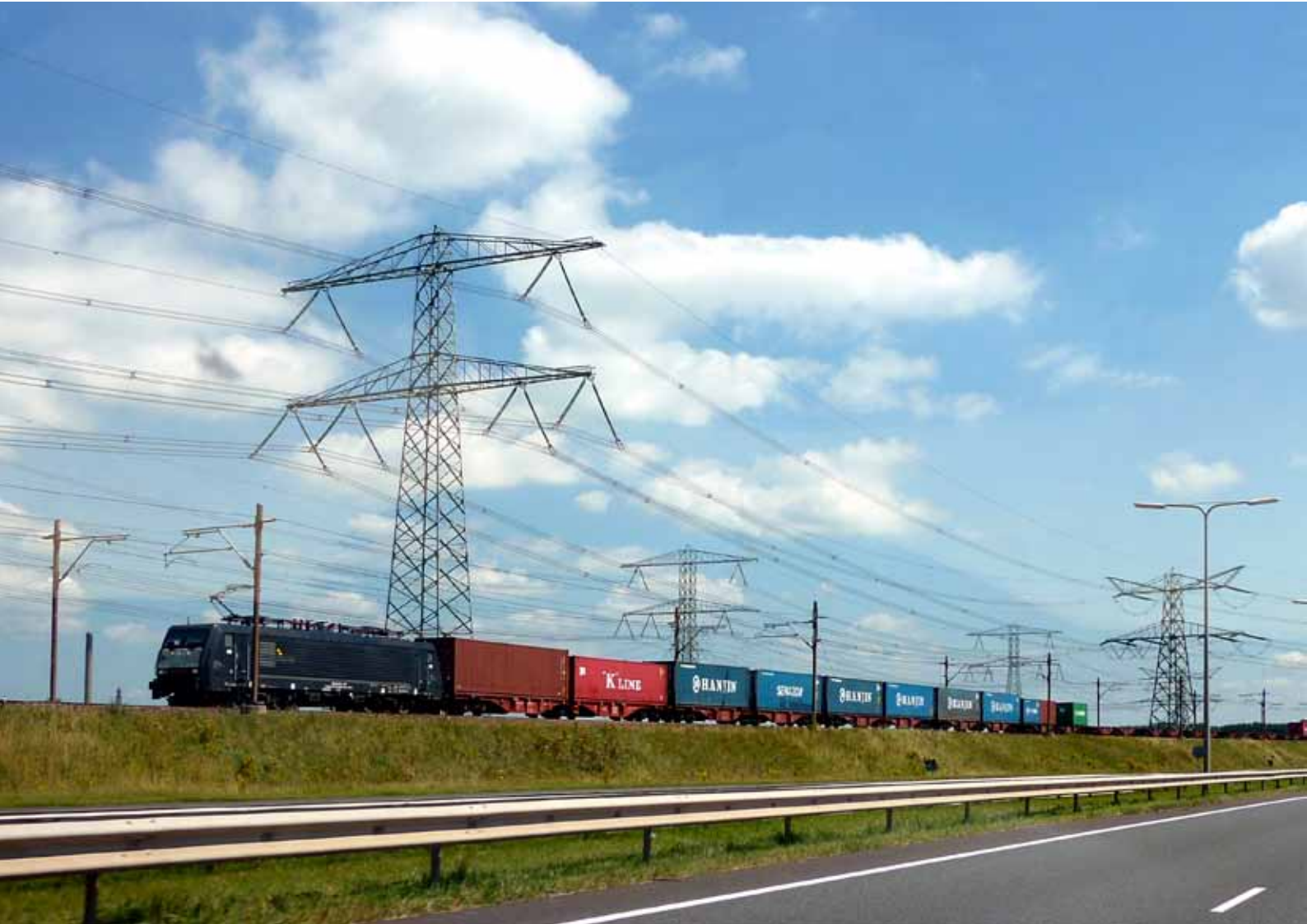
Op de Havenspoorlijn wordt gebruik gemaakt van ERTMS Level 1. (Foto Keyrail)
