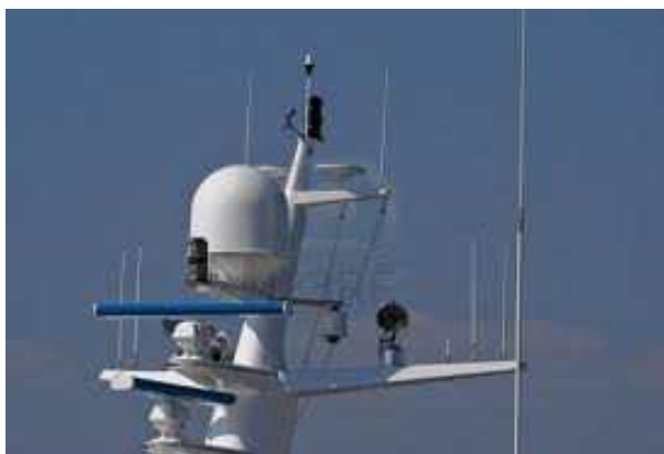
Figuur 40. Voorbeeld van de montage van de antennes van een scheepsradar op de masten
