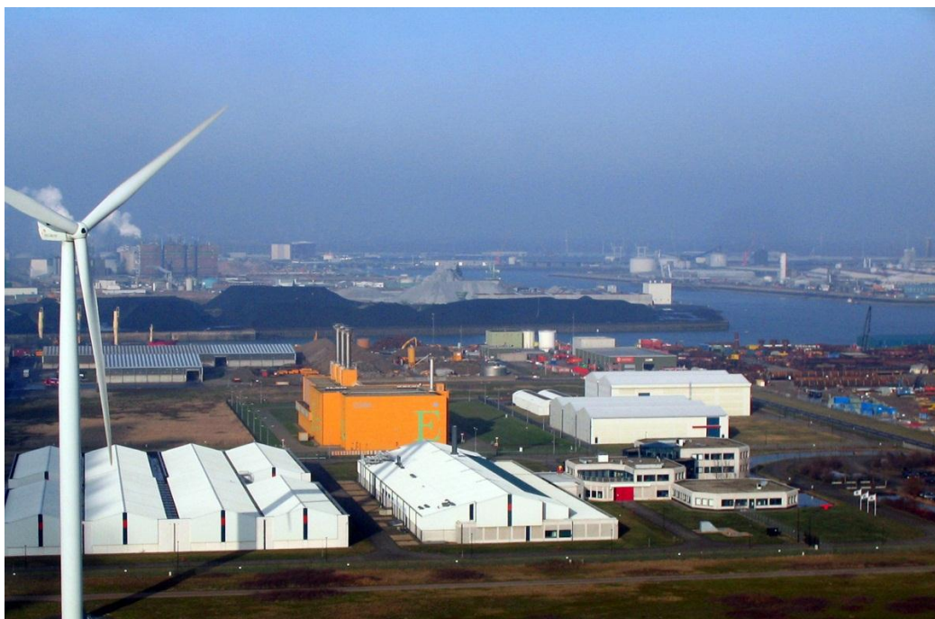
Afbeelding 3: Foto bestaande gebouwen COVRA (2010)
