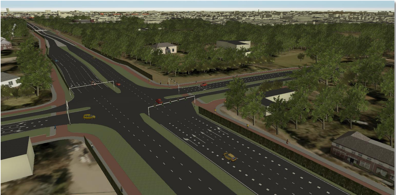
Figuur 7 Bovenaanzicht van het kruispunt van de Boslaan en Vijverbosweg met de N65 Op de achtergrond ligt de ongelijkvloerse kruising bij de Martinilaan en De Bréautélaan. Aan weerszijden van de N65 ligt een fietspad in twee richtingen.
