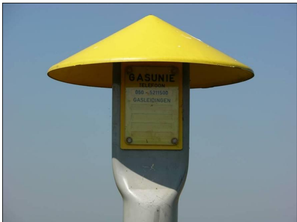
figuur 1.1 Markering buisleiding (foto: Antea Group )
